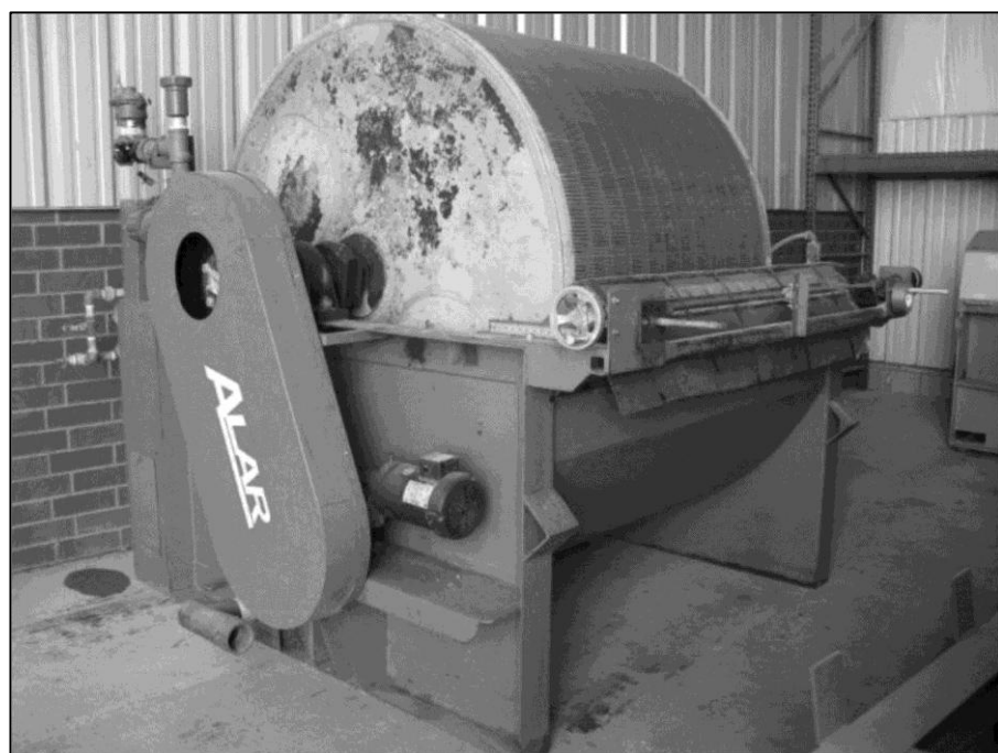
الشكل (10-3): صورة تبين وحدة الترشيح بالانفراغ لنزع رطوبة الحمأة
