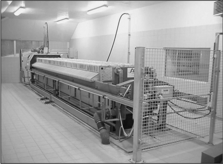
الشكل (9-15): يوضح صفائح وجريان الحمأة في المكبس المرشح
